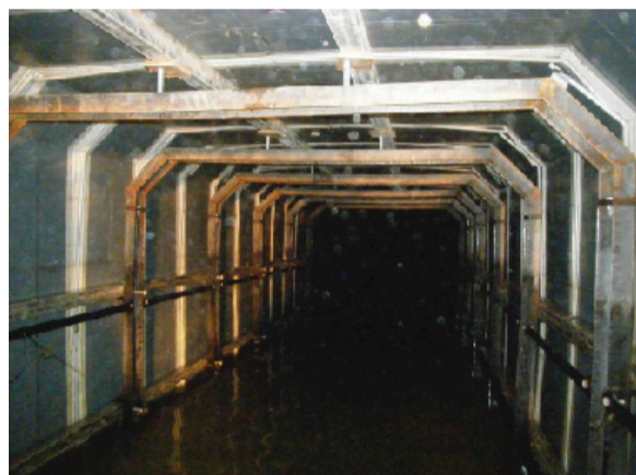
フレーム施工
