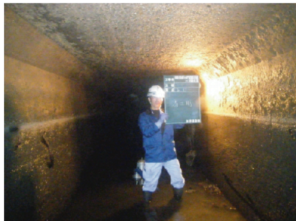
準備工（腐食部除去）
